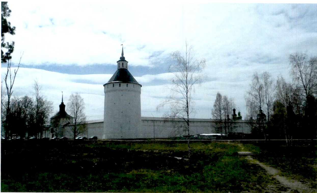
Тр-6.3. Вид объекта культурного наследия федерального значения Ансамбля Кирилло-Белозерского монастыря», XV-XVII вв. с улицы Пролетарской
