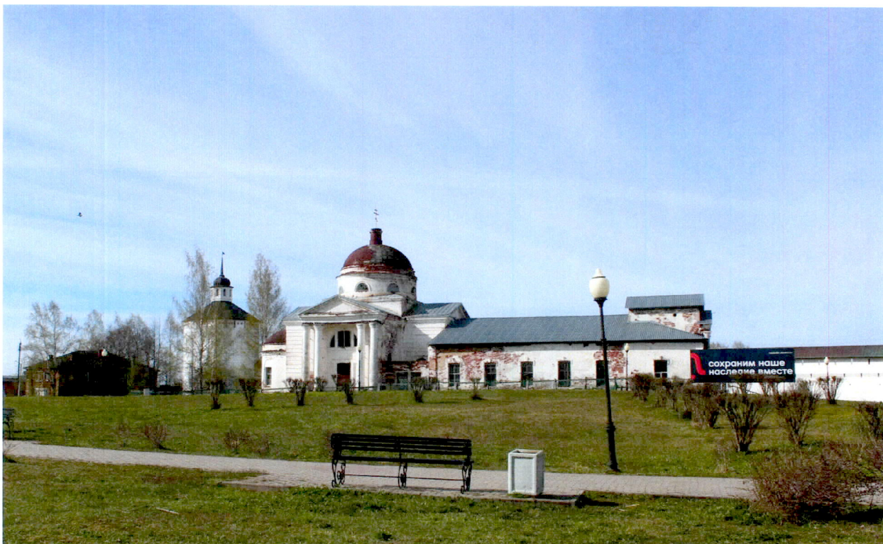
Т-4. Вид объекта культурного наследия Казанская церковь, начало XIX века со стороны сквера
