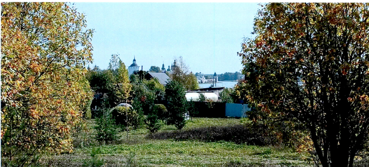
Т-1. Вид на объект культурного наследия федерального значения Ансамбль Кирилло-Белозерского монастыря, XV-XVII вв. с открытой площадки повышенного рельефа за участками домов № № , 28, 26 по ул. Строителей
