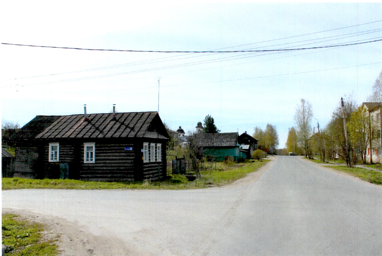
Т-6. Вид объекта культурного наследия Церковь Вознесения Господня с приделом Иоанна Воина, 1798 г. от перекрестка улиц Симоновской и Пролетарской
