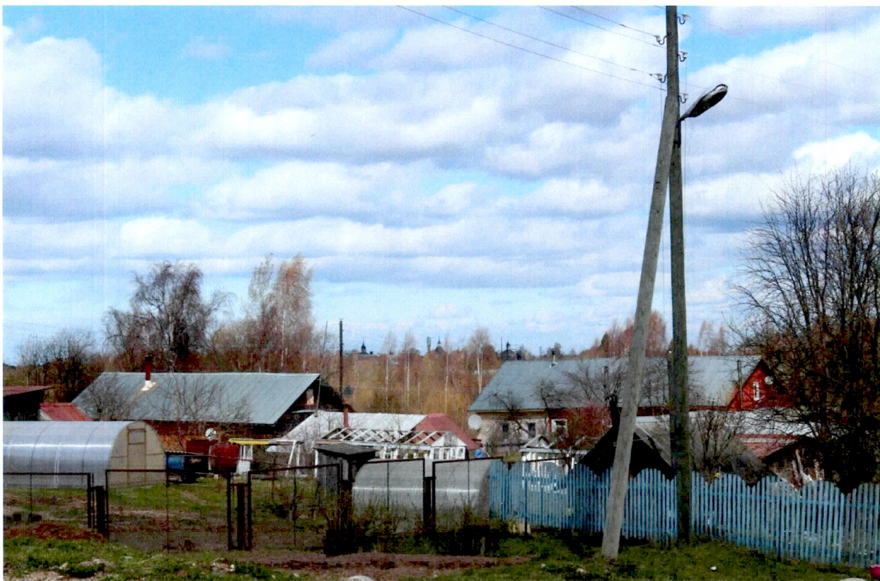
Тд-5. Вид объекта культурного наследия федерального значения Ансамбль Кирилло-Белозерского монастыря, XV-XX вв. с улицы Красной
