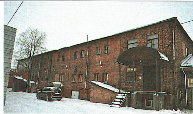
«Малое хранилище», вид с юго-востока
