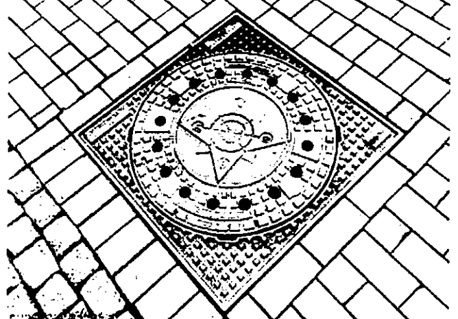
Сохранение ритма кладки с помощью применения круглого люка с квадратным обрамлением.
