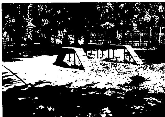
Отсутствие ограждений площадки, применение однотипного игрового оборудования.
