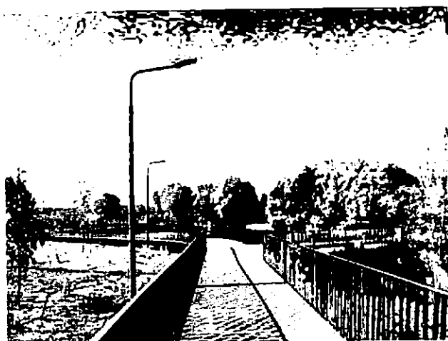
Установка проницаемых ограждений для отсутствия визуальных барьеров.
