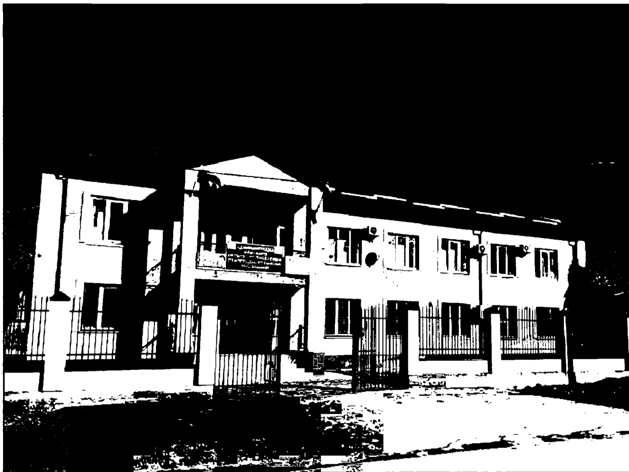
Рис. 42. Здание администрации Майского сельского поселения на улице Центральная
