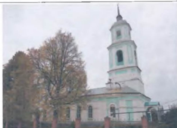
Вид объекта с севера.
