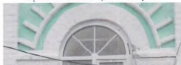
Фрагмент оконного проема придела трапезной.
