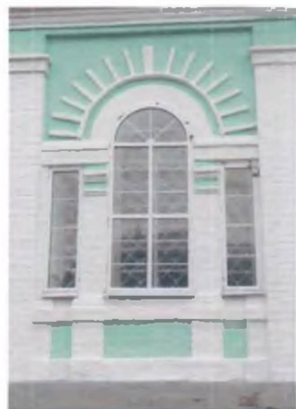
Окно южного фасада притвора (южного крыла).
