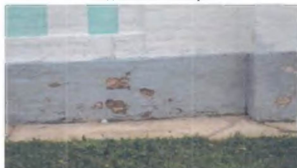
Фрагмент южного фасада.
