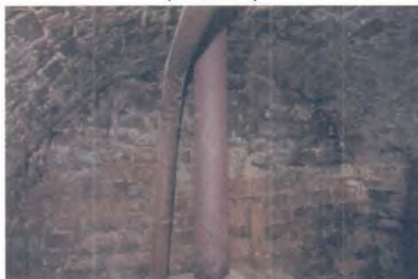
Фрагмент интерьера, свод северного крыла притвора (котельной).
