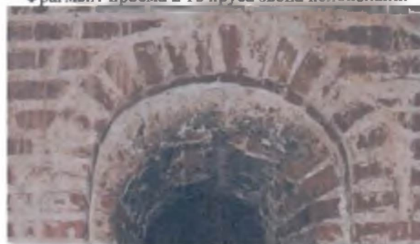
Фрагмент дверного проема колокольни.
