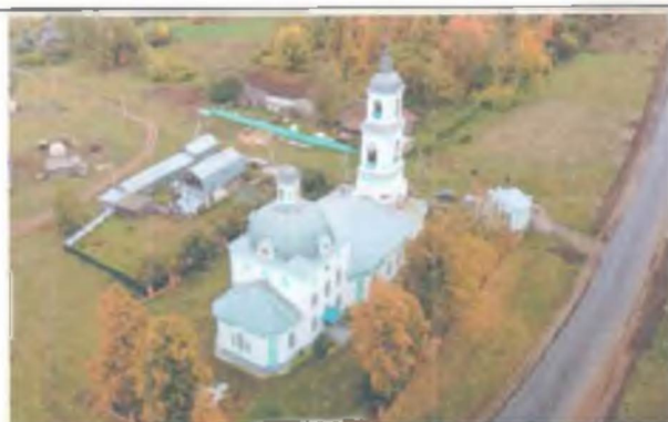
Общий вид объекта с северо-востока.
