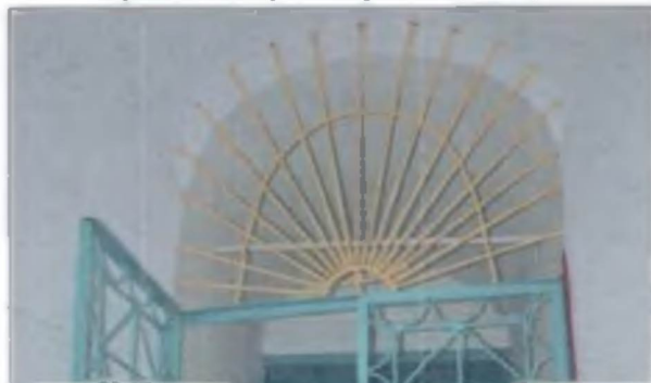
Фрагмент дверного проема западного входа.
