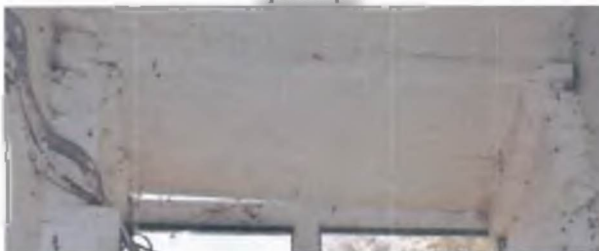
Фрагмент (перемычка) оконного проема северного крыла притвора.
