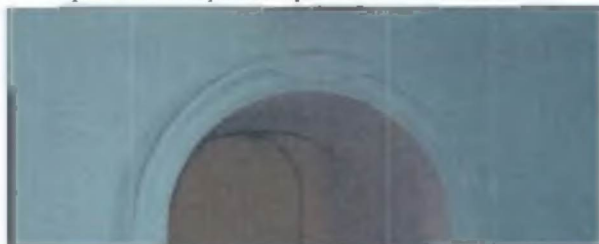
Фрагмент дверного проема алтарной апсиды.
