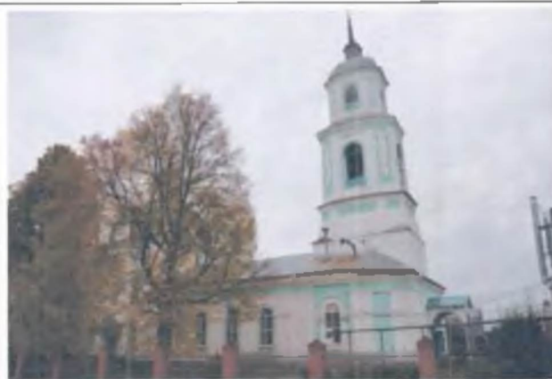
Вид объекта с севера.
