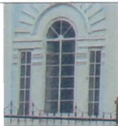
Трехчастное окно алтарной апсиды, исторический рисунок оконных переплетов.
