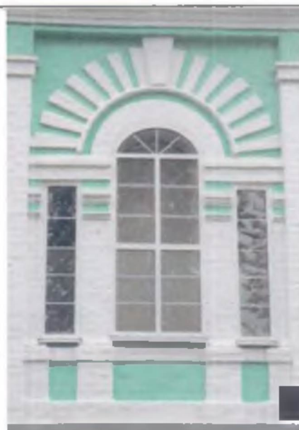
Окно восточного фасада алтарной апсиды.
