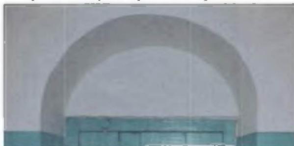
Фрагмент дверного проема котельной.
