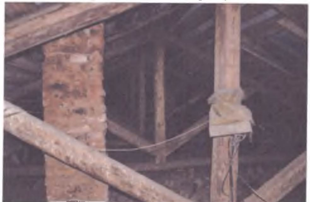
Фрагмент крыши (чердак).
