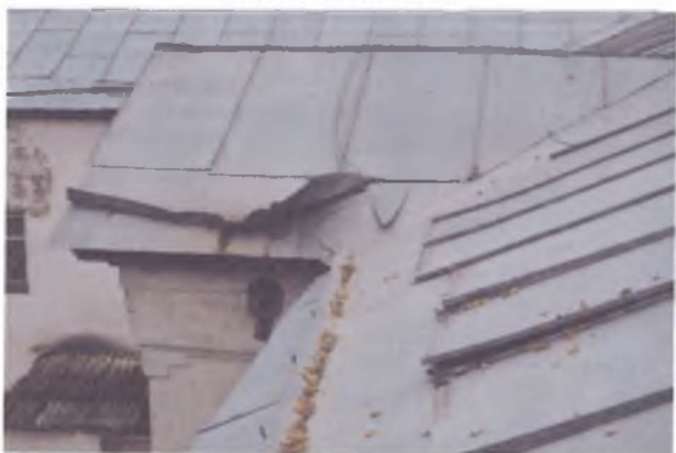
Фрагмент покрытия кровли.
