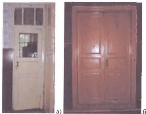
Двери 1-го этажа объема 1957 года: а) Дверь в помещение, б) Дверь тамбура.
