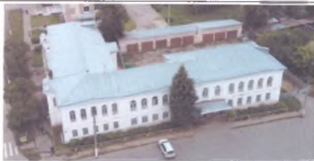
Вид объекта с юга.
