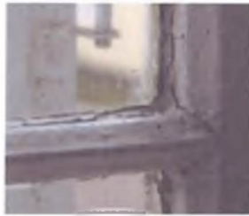
а) Форма калевки окна Типа 1; б) Форма калевки окна Типа 2.
