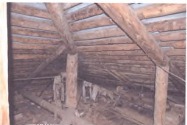
Фрагмент крыши (чердак).
